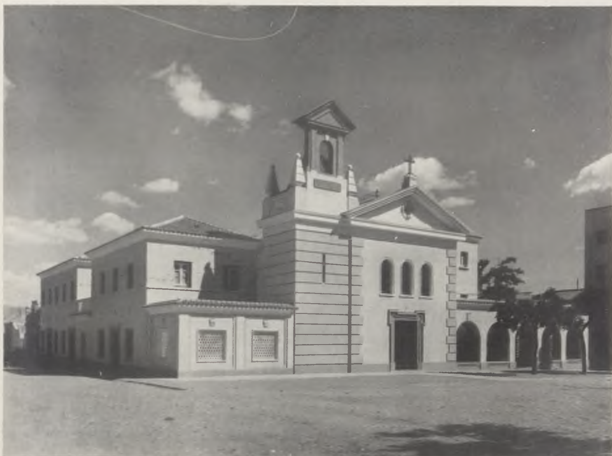
Fachada de conjunto. —
