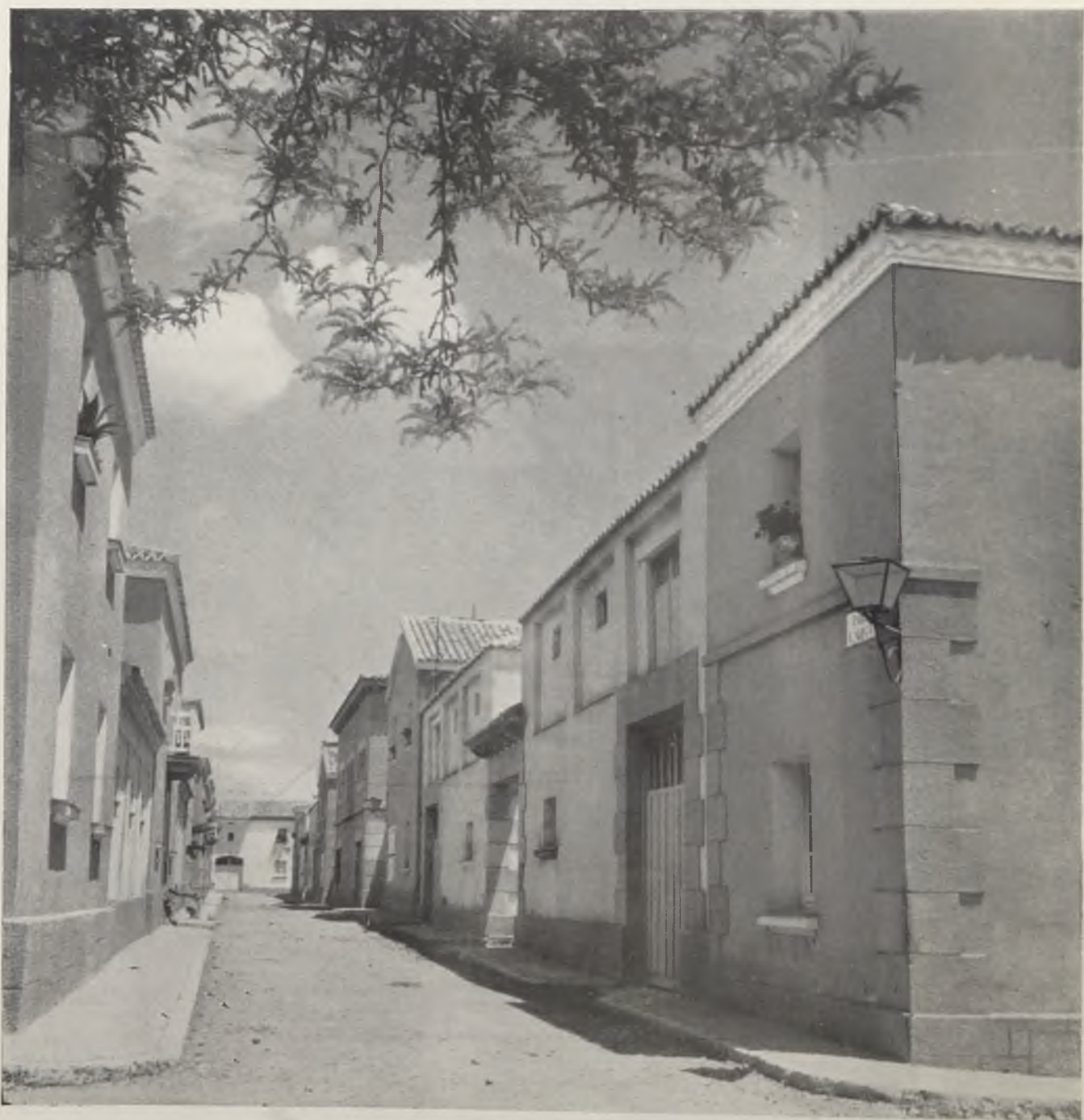
MASEGOSO.—Una calle con nuevas viviendas.
