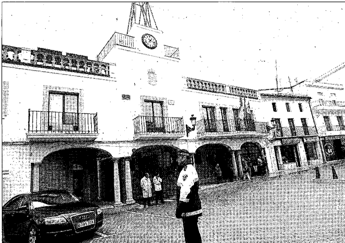
Fachada del Ayuntamiento de Almadén. / LT
