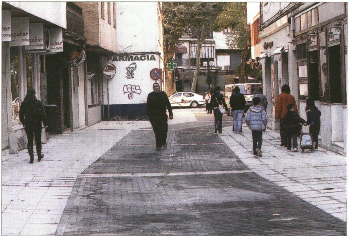
La calle Montesa ha ganado amplitud con las obras de mejora. / RUEDA VILLAVERDE
