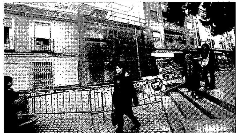
Edificio de la calle Lanza que sufrió un desprendimiento el miércoles. / RUEDA
