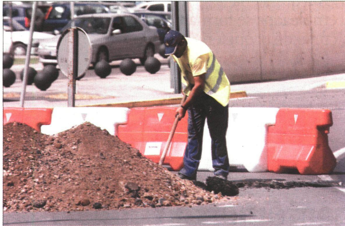
Un obrero trabaja en unas obras en Ciudad Real. / RUEDA VILLAVERDE
