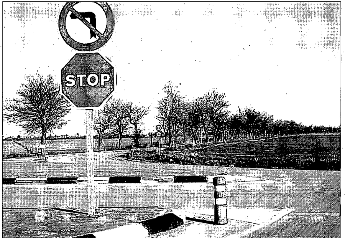
Semiglorieta de la CM-3107, a la altura de Llanos del Caudillo, que será modificada con la reforma de esta carretera. / LT
