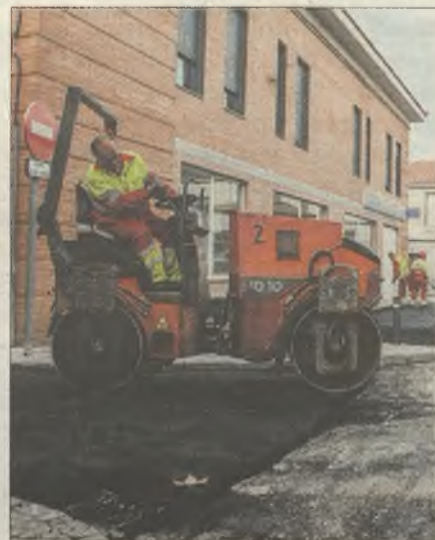
Una de las últimas obras ejecutadas.
