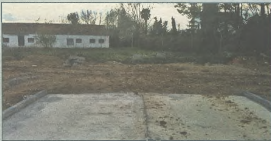
Vial interrumpido en El Ruiseñor por edificios que el alcalde se negó a expropiar.
