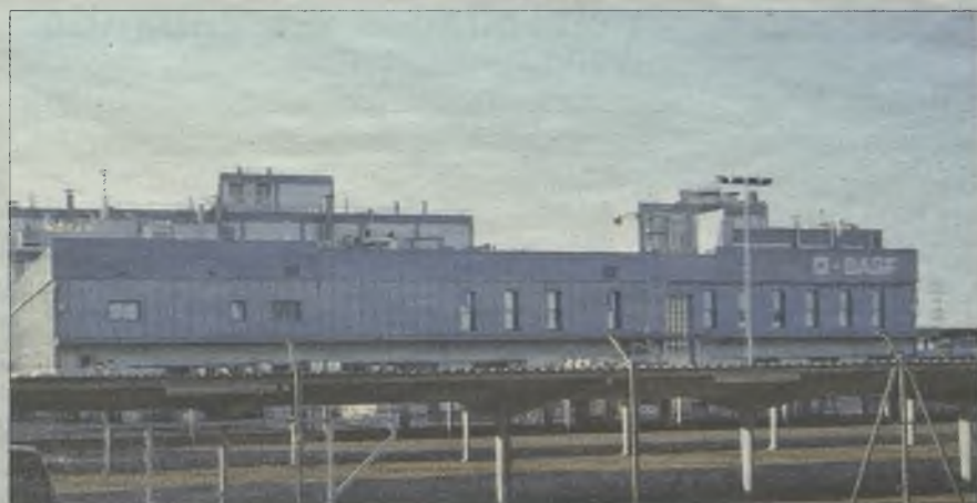
Planta industrial de BASF en Marchamalo.
