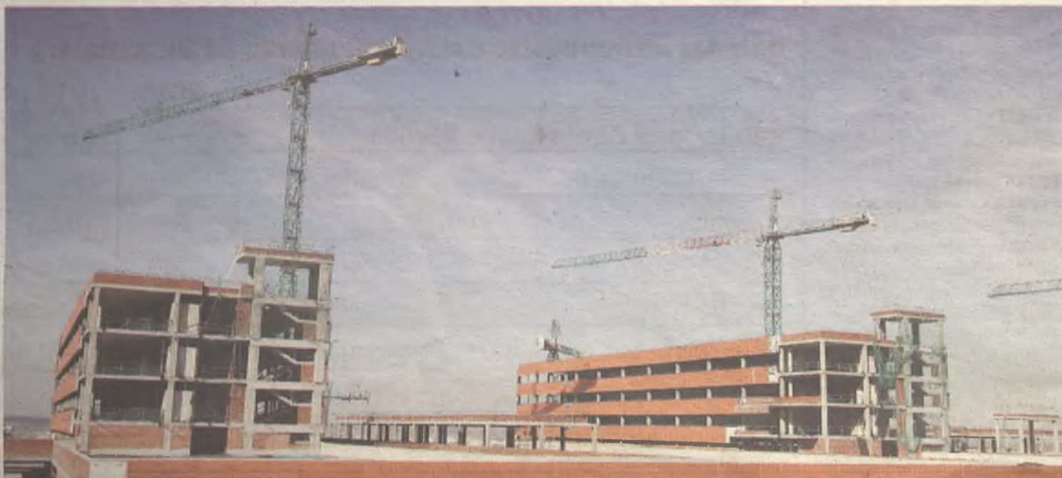
La ampliación del Hospital Universitario arrancará de nuevo sus obras en los próximos meses. / FOTO: EDUARDO BONILLA
