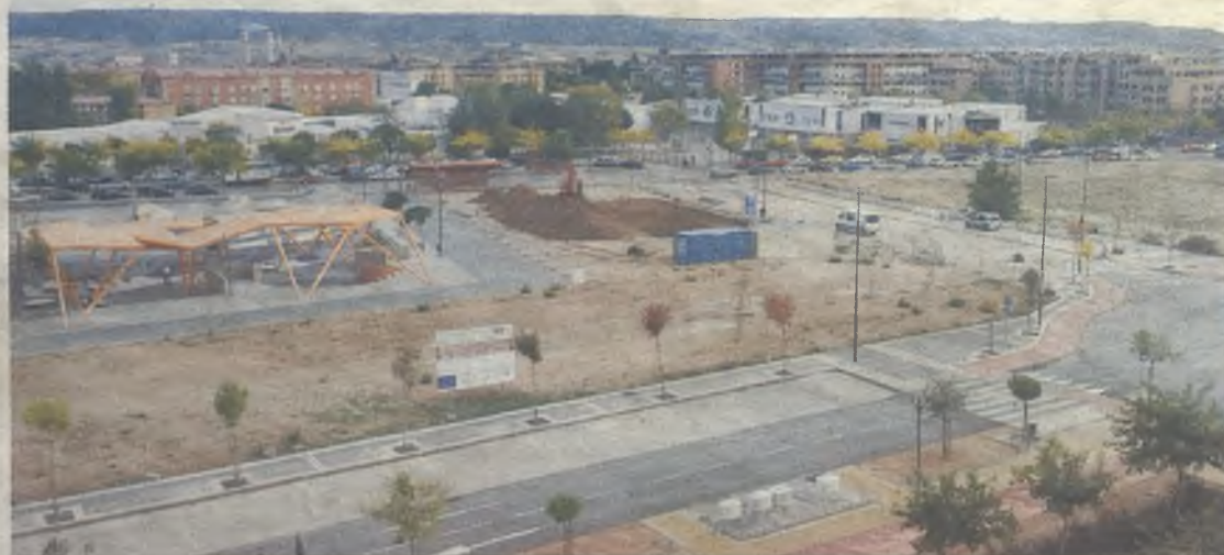
Los trabajos de la multinacional McDonald's ya han comenzado en la parcela del Ayuntamiento de Azuqueca.
