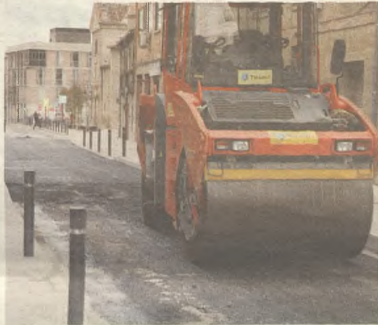
La pasada semana se asfaltó el tramo central del Eje Cultural. / FOTO: JESÚS ROPERO
