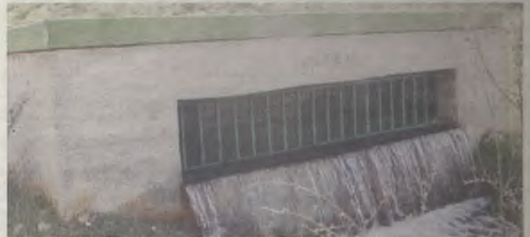
Los trabajos para probar el correcto funcionamiento los está realizando personal de la MAS.
