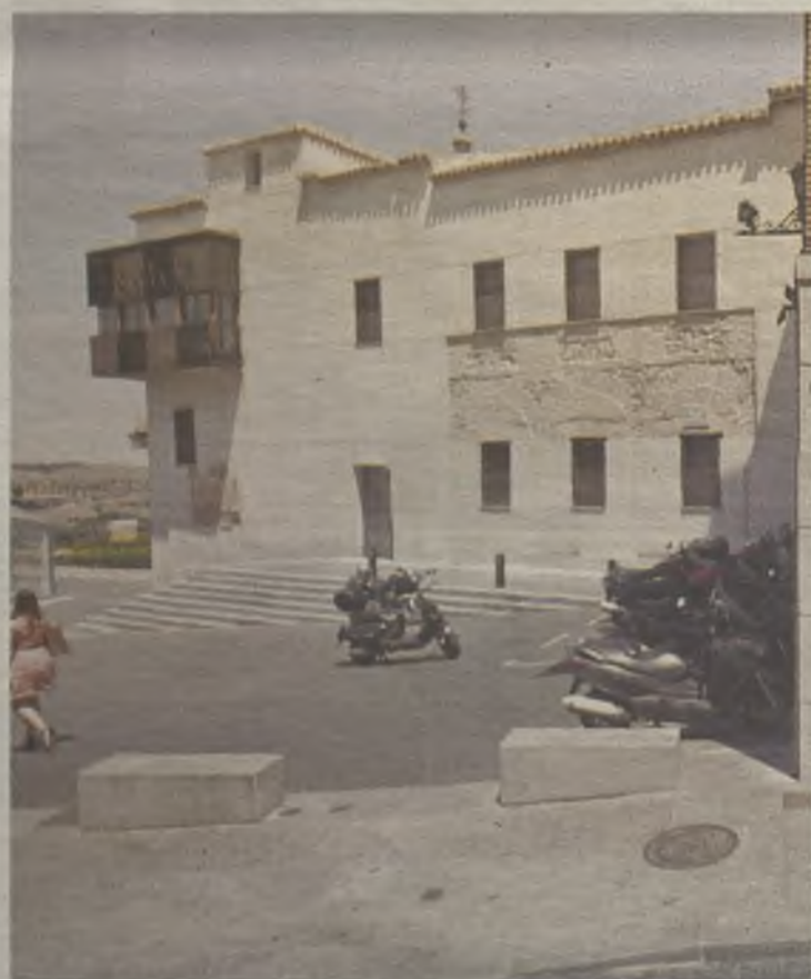
Este espacio ha sido recientemente remodelado.
