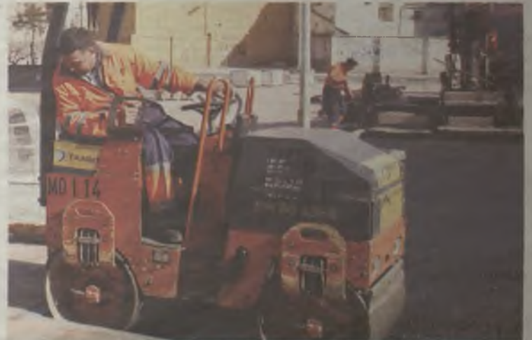
El asfaltado del entorno de Santa María marcha a buen ritmo. / FOTO: JESÚS ROPERO
