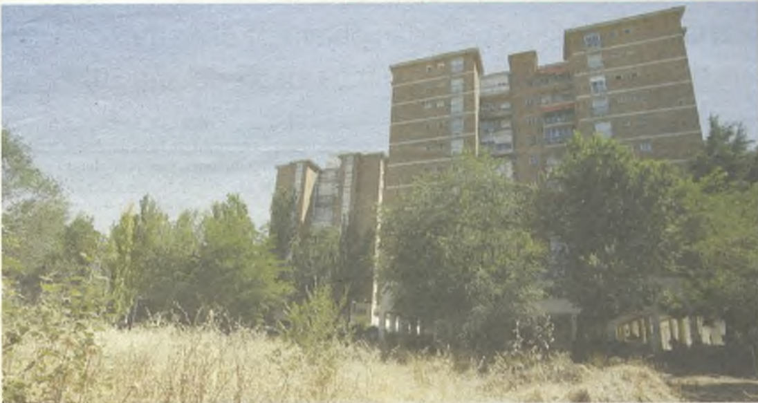
Zona en la que se ubicará el futuro parque de Las Torres./Eduardo Bonilla
