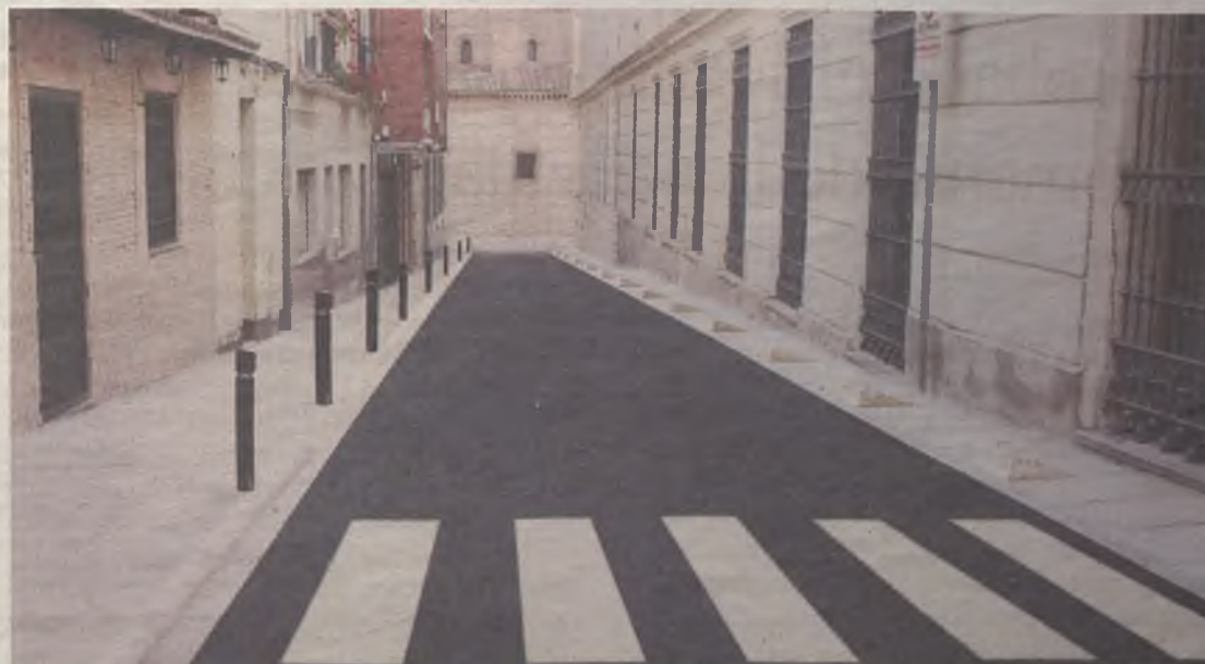
Este será el resultado de las obras en la calle Cronista Juan Catalina./Gu30D
