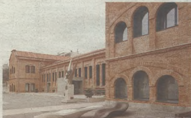
El Cuarterel del Henares ha sido completamente remodelado./J.R.
