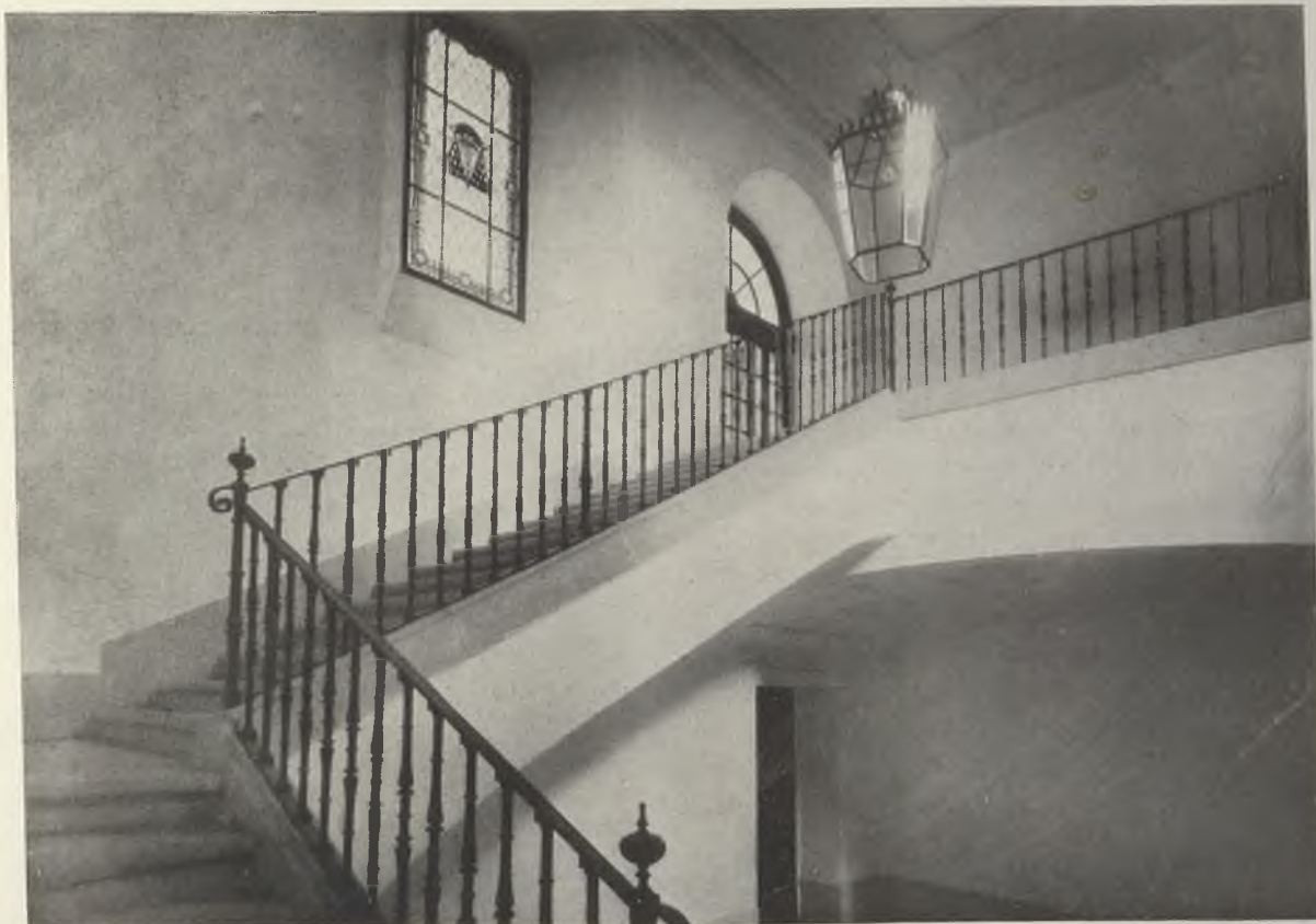
Seminario, Interior. Detalles de una escalera y de una vidriera de la capilla.
