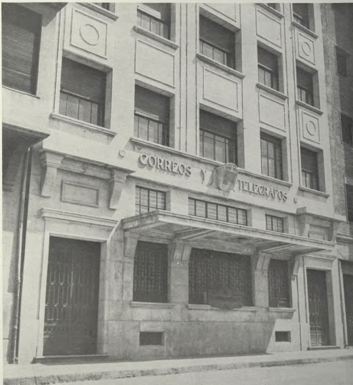
Detalle de la fachada principal.
