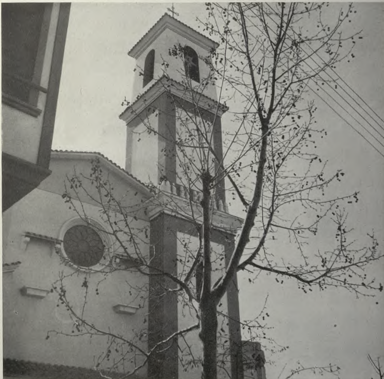
BENISANET.—Torre de la iglesia.
