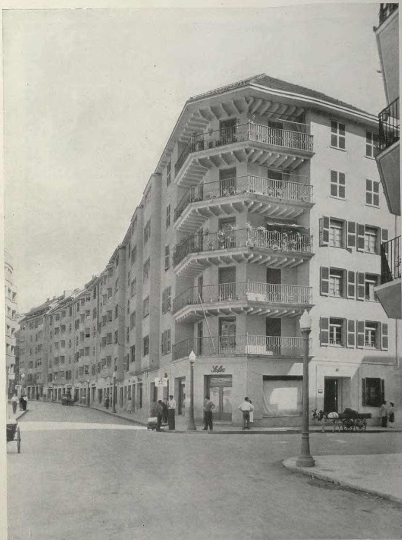
EIBAR.—Bloque de viviendas en la calle de María Angela.
