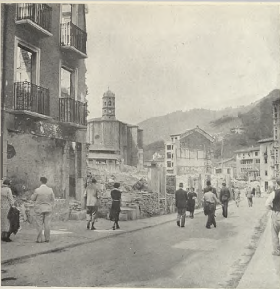
EIBAR, en 1938.—En estas ruinas se ha construido el nuevo Mercado, frente al Bloque de viviendas. Abajo: Fachada principal del Mercado.
