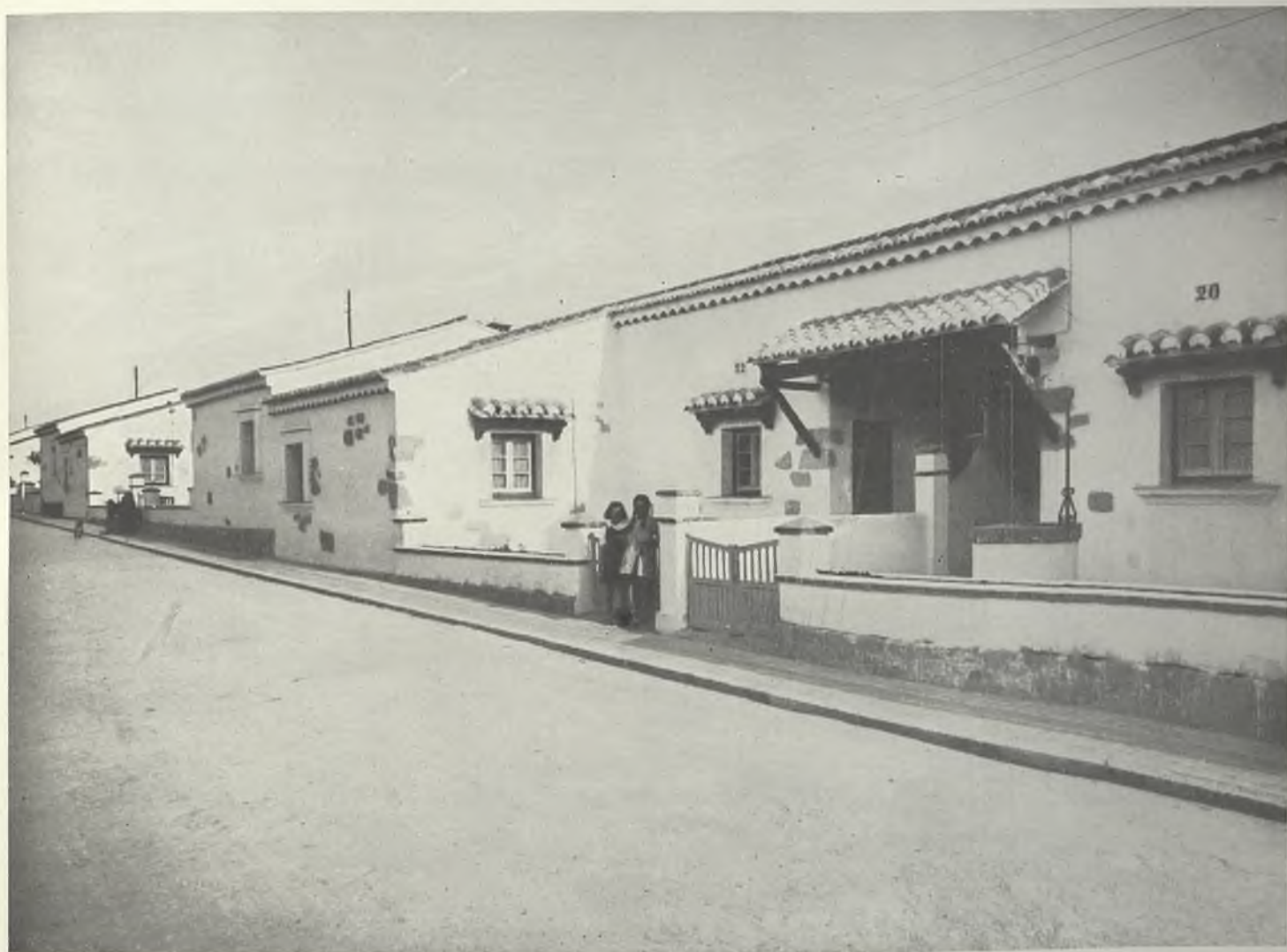
Viviendas para labradores en el pueblo de Aravaca.
