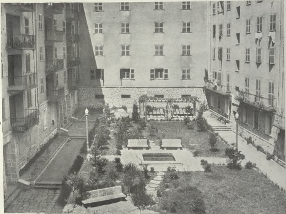
Bloque de viviendas en la calle de María Angela, de Eibar. Patio donde se eleva hoy este grupo de viviendas; un hacinamiento de viviendas y talleres impedía la construcción regular en gran escala. La expropiación forzosa allanó servidumbres y condominios, pasos de agua, luces y mancomunidades de pasos y de patios, logrando la superficie, limpia de derechos reales, necesaria para iniciar tan importante construcción.
