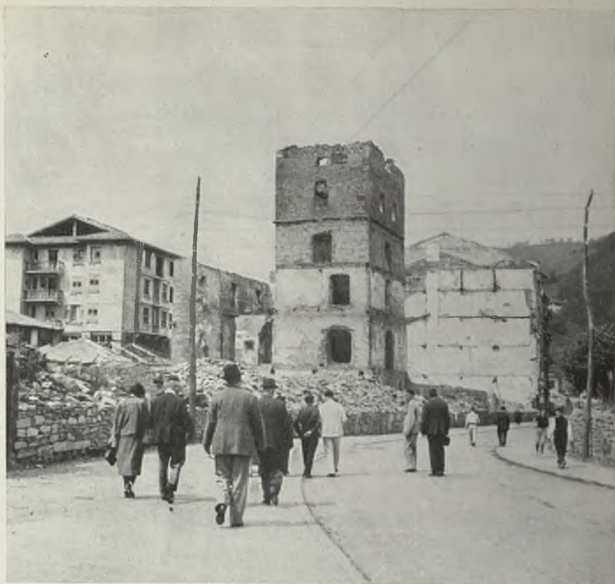
EIBAR, en 1938.—En estas ruinas se ha construido el Bloque de viviendas de la calle de Maria Angela. Abajo: Vista parcial del Bloque.
