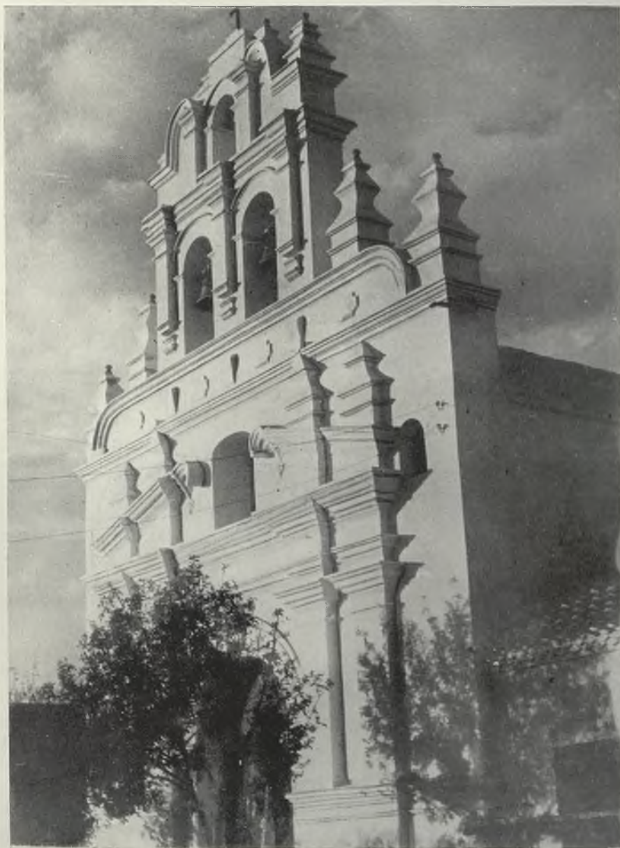
SUCRE.— Fachada del Templo de San Lázaro, ya reconstruida.
