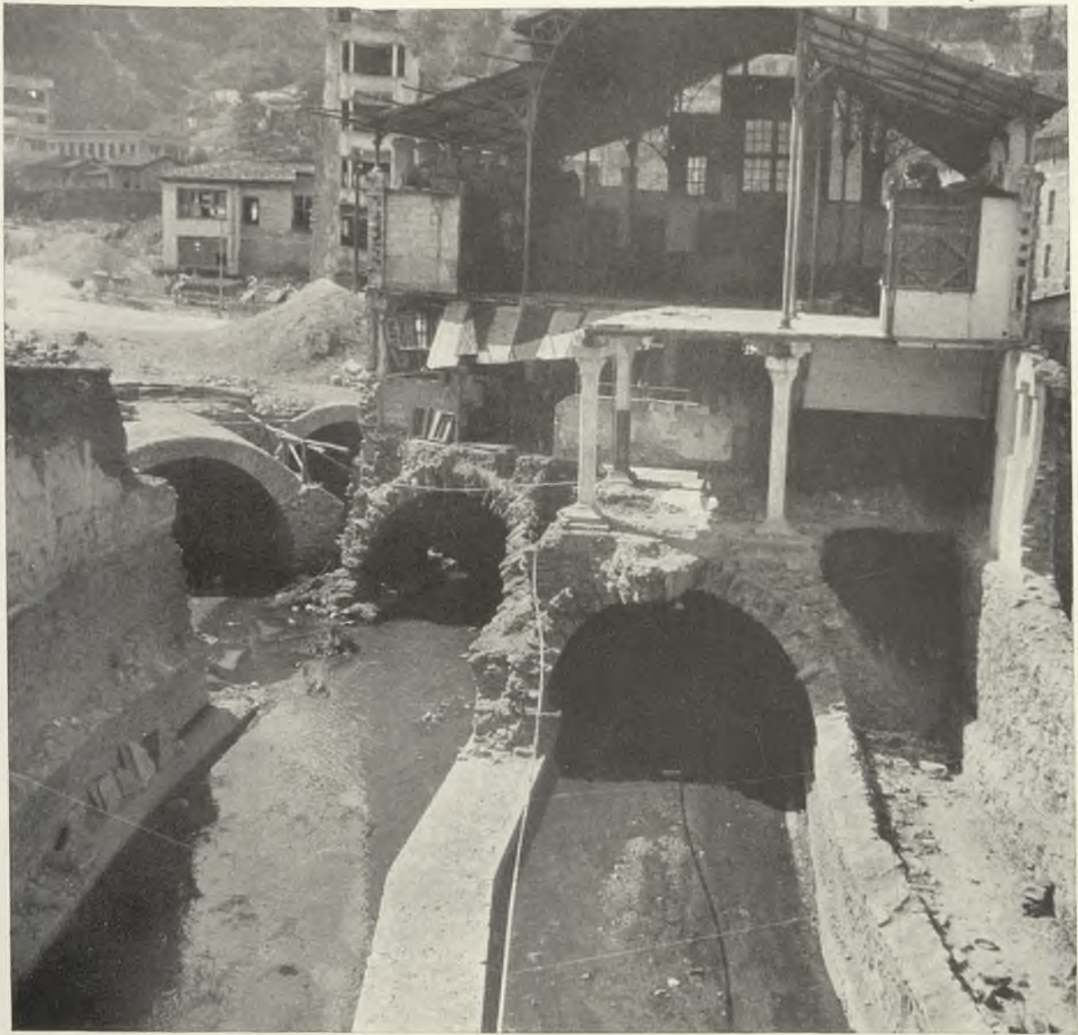
EIBAR.—Obras de cubrimiento del río Ego, en 1944.
