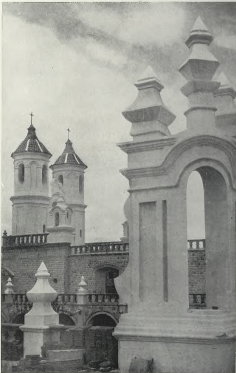
SUCRE.—Torres de San Felipe Neri, ya terminadas.
