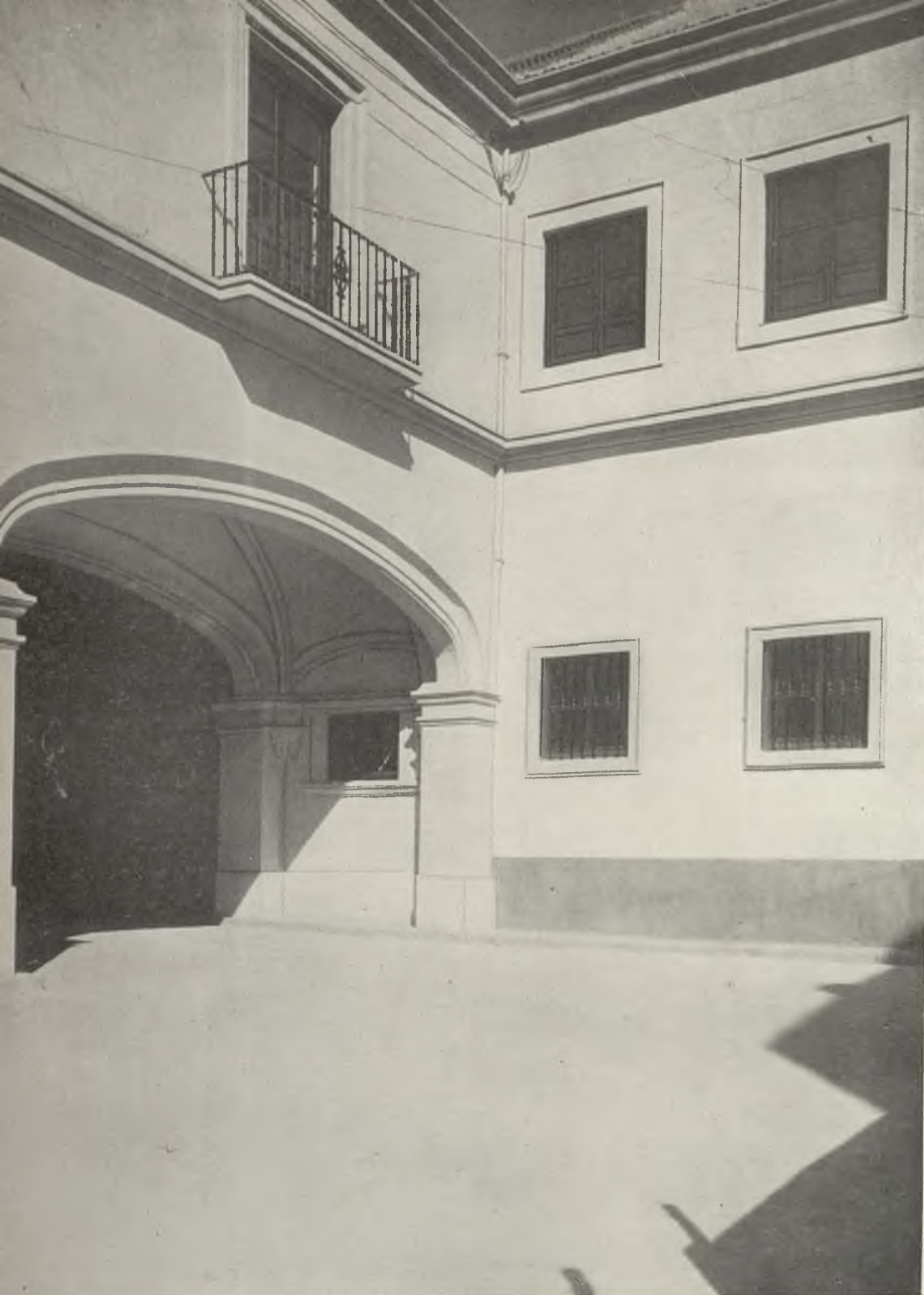
Ayuntamiento. Fachada posterior.
