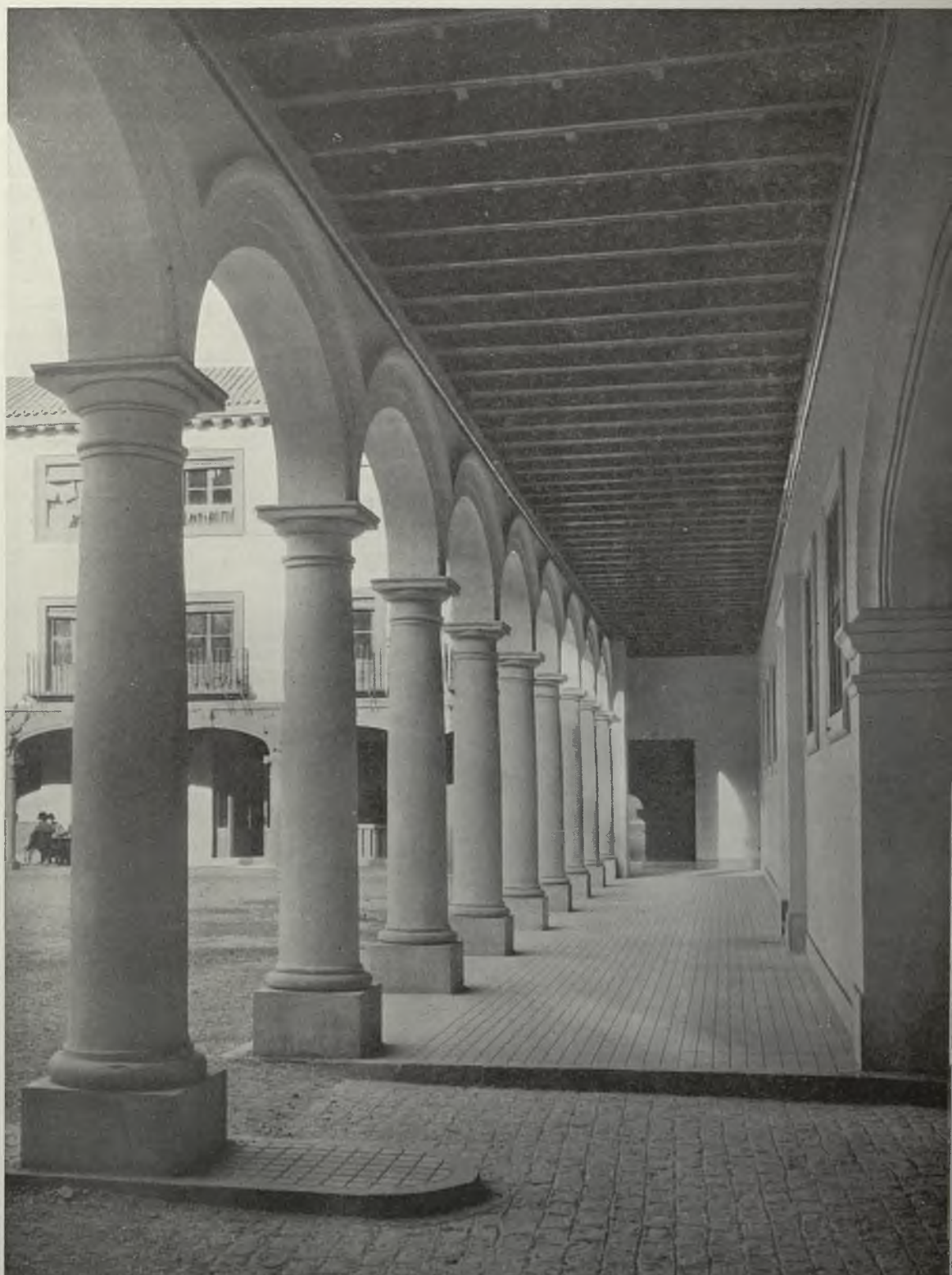
Ayuntamiento. Balcón de Corregidores. Soportales de la planta baja.
