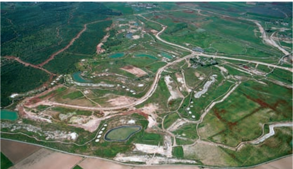
Estado actual de las obras a finales de 2007. Arriba: Asfaltado de accesos.
