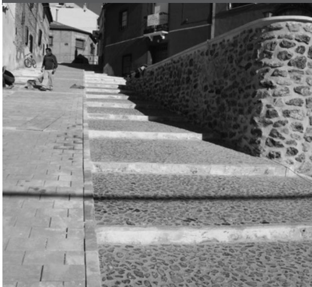
Escalerillas casi terminadas
