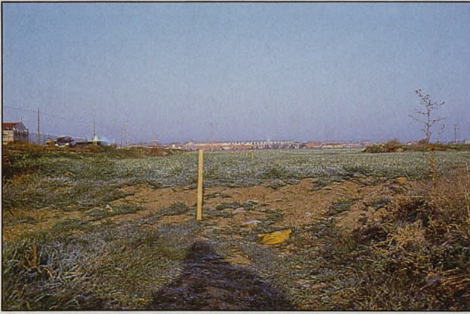
La zona donde se ubicará la variante de la carretera Toledo-Avila ya ha sido acotada con estacas.
