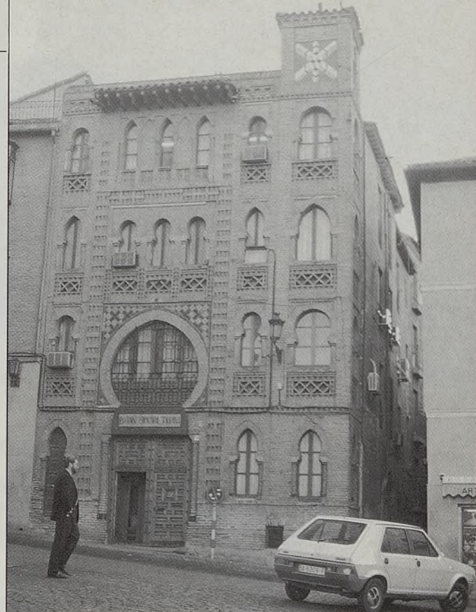
El edificio de la Cuesta del Alcázar trae de cabeza a los directivos de Fedeto desde hace más de año y medio.
