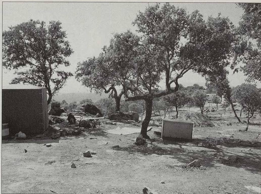
El material que utiliza Ciemat en El Berrocal es similar al que se utiliza para realizar cualquier pozo. Al fondo de la imagen se aprecian las instalaciones de un equipo de investigación francés.
