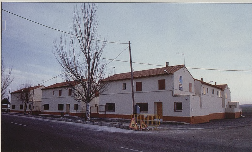
La Junta de Comunidades ha construido 22 viviendas en Las Casas. Las listas definitivas para su adjudicación saldrán el próximo mes.
