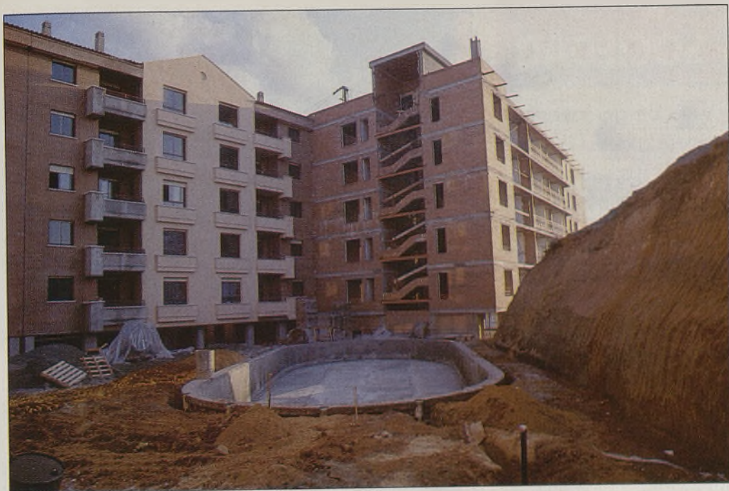
Las ventanas del apartahotel —el edificio de la derecha— tienen sus vistas hacia la piscina común de las viviendas municipales.
