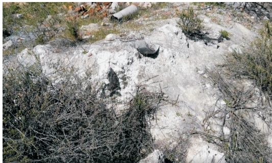
Uno de los focos de vertidos de amianto en el barrio, foto archivo.
