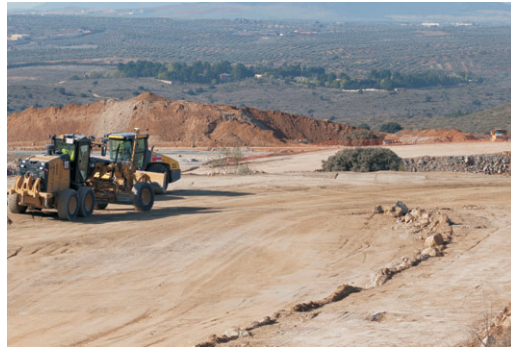
Obras de Puy du Fou.
