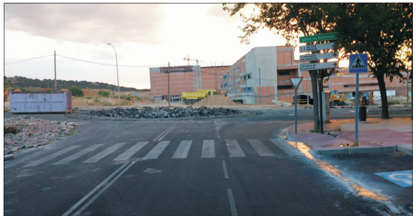
Obras de la rotonda en Fresnedoso en su confluencia con Estenilla.
