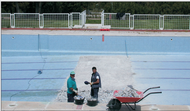
La piscina de verano en una reparación sobre 2005.
