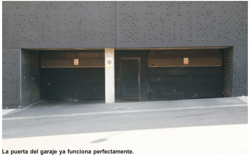
La puerta del garaje ya funciona perfectamente.
