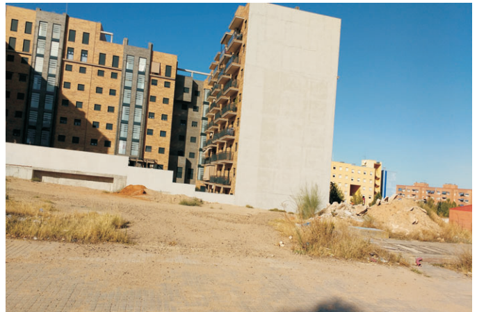
Estado del espacio posterior de la parcela donde se ha realizado la construcción de las últimas viviendas sobre la calle Fresnedoso, a la espera de que la Junta de Comunidades saque a licitación la parcela.
