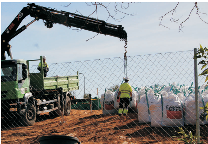
Retirada de amianto en Laguna de Arca.
