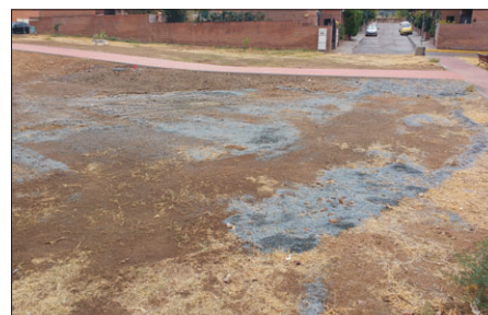
Vertido de hormigón de la obra.
