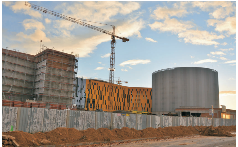
Las obras del hospital han tomado un ritmo frenético.
