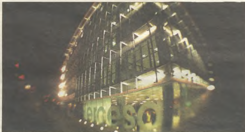
Fachada de la sede central de Hercesa, en Guadalajara
