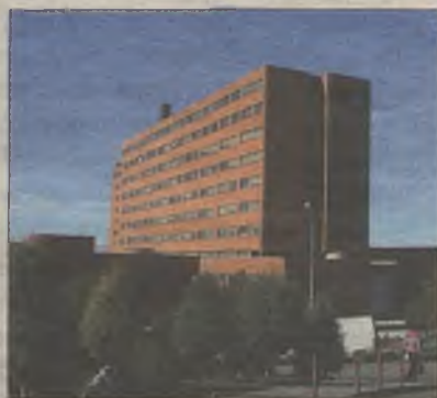
Fachada del Hospital de Guadalajara
