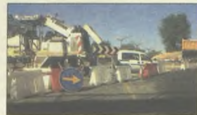
Imagen de las obras de la rotonda
