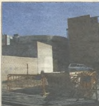
OBRA. Una de las parcelas en reforma
