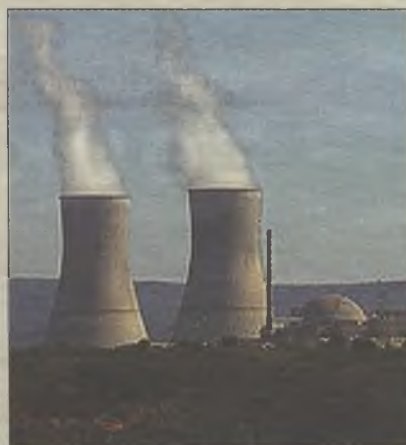
Imagen de la Central de Trillo
