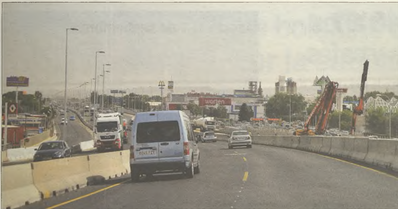
GRAN INTENSIDAD. El tercer carril de la autovía A-2 soluciona uno de los grandes problemas circulatorios de esta vía
