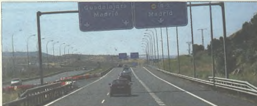
La Radial 2 es una de las autopistas que más conductores ha perdido
