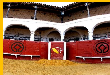
Tendidos bajo y alto recuperados (S. XX)
