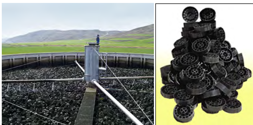
Figura 3: A la izquierda: Tanque con lechos bacterianos. A la derecha: Imagen de los discos utilizados para formar la biopelícula.
