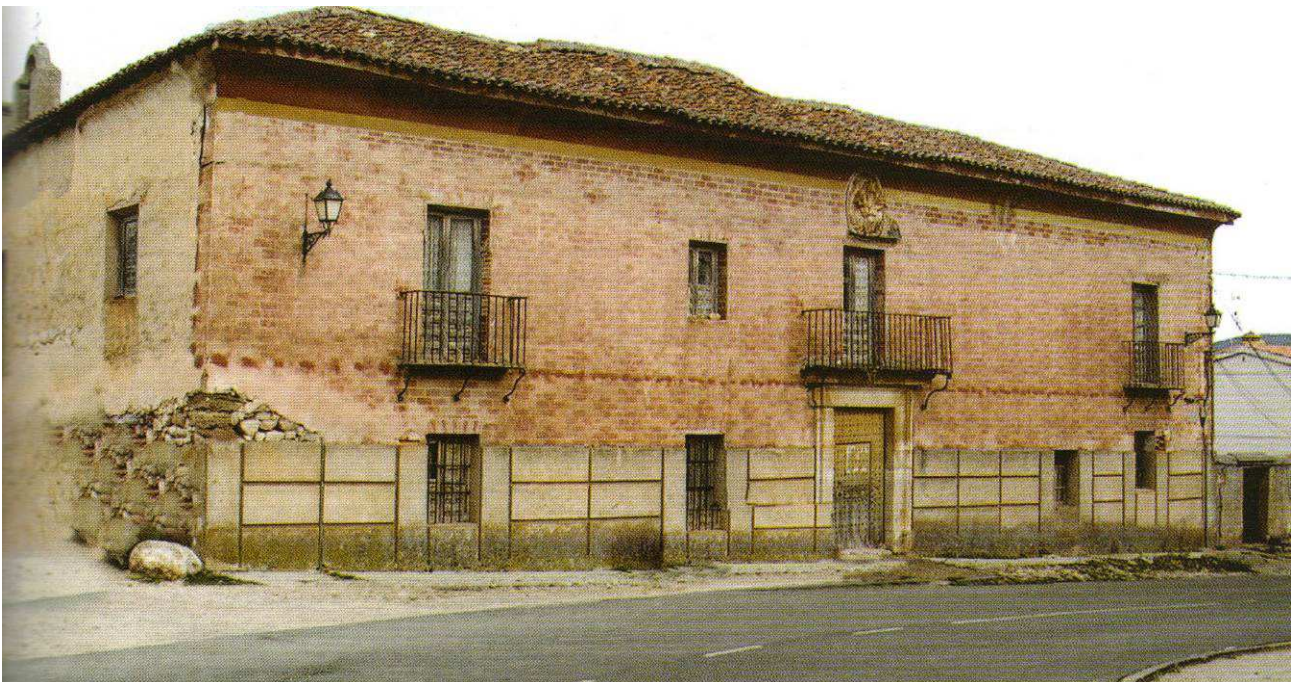
Atienza. Antiguo Hospital de Santa Ana, remodelado por los hermanos Pascual en los inicios del siglo XX, y donde se instituyó la Fundación Benéfica de doña Francisca.
