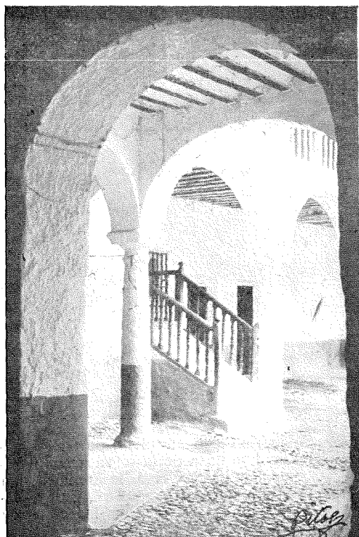
Entrada y escalera de la casa grande, posada de San Carlos del Valle que tiene marcada a fuego en la falleba de su portada la fecha del año 1704.
