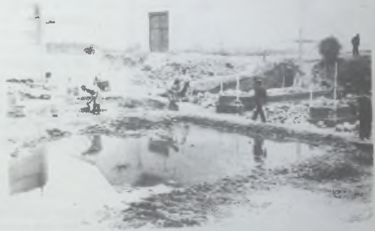
CONSTRUCCION DEL PUENTE "COMUNMENTE LLAMADO DE FELICIANO" Que sustituyó a l antiguo vadillo que atravesaba el camino del acacer o "Camino Mondo" (Cortesía de D. Crisanto Ortega)
