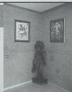
Detalle en pintura estuco
