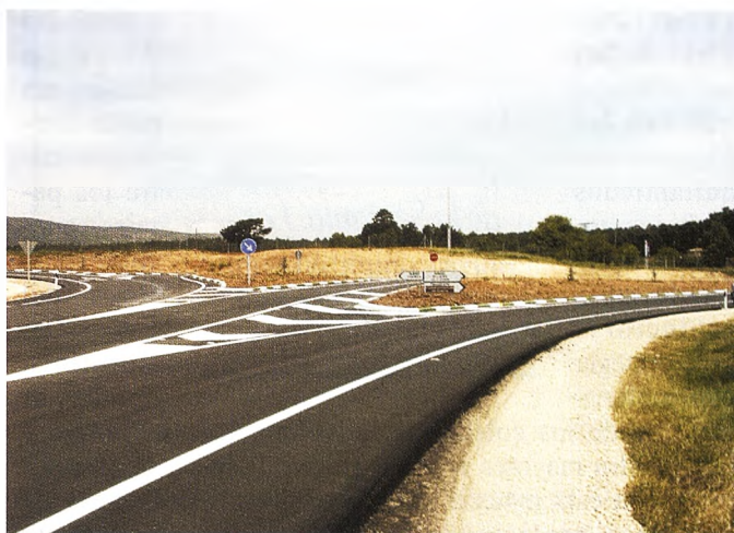
Cruce construido entre el Caserío de Embid y 'El Chantre' para enlazar la Variante Noroeste con la CM-2105.
