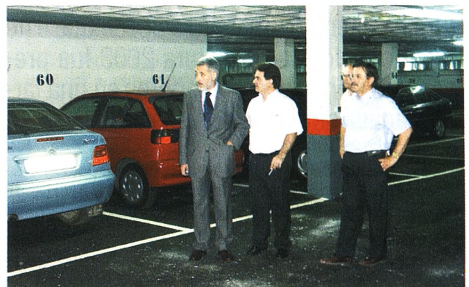
Entre las mejoras destaca un nuevo suelo de asfalto que viene a sustituir el existente de cemento.
