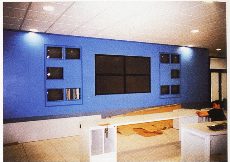
El Centro de Pantallas, centro neurálgico del sistema de Centralización Semafórica, se ubica en las dependencias de la Policía Local. Diez monitores de 28 pulgadas permitirán receptionar en todo momento las imágenes recogidas por las diez cámaras instaladas en las arterias y cruces más importantes de la ciudad.
